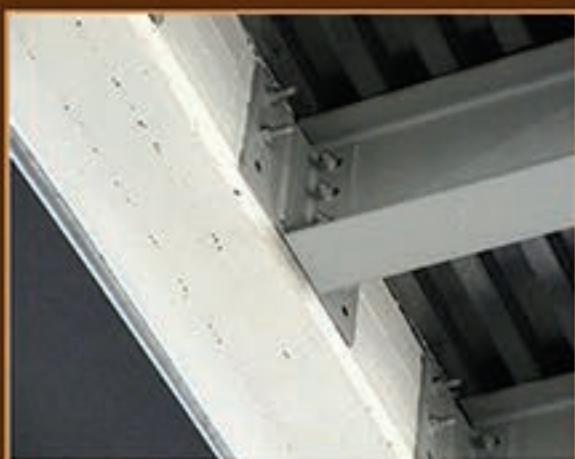
Attache d'une poutre en acier sur une poutre béton existante
