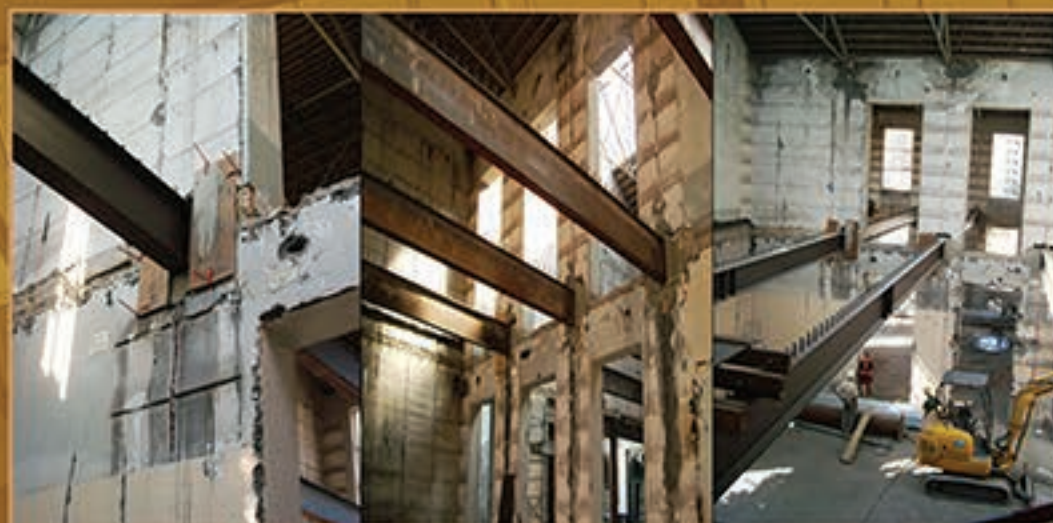
Poutres mixtes traversant le mur support
