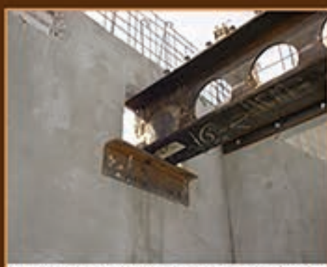
Attache d'une poutre acier sur une poutre béton existante
